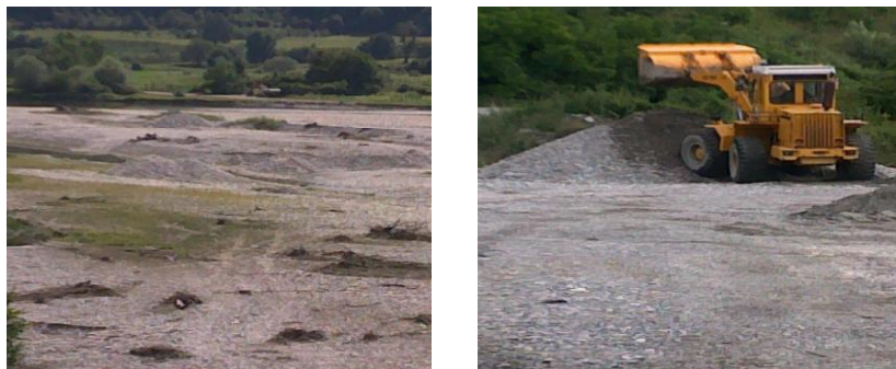
Slika 3. Lokacija eksploatacije šljunka i pijeska (Zaton)
